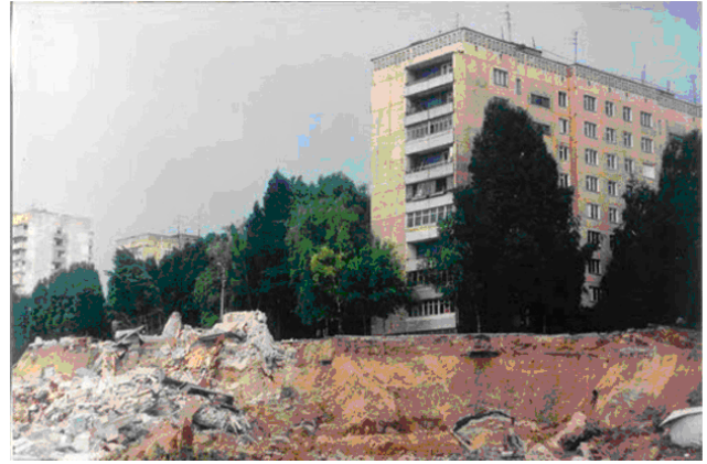
Рис. 12. Руины дома № 22 в оползневой воронке и чудом уцелевший дом № 20. Фото Geozond. 1997
