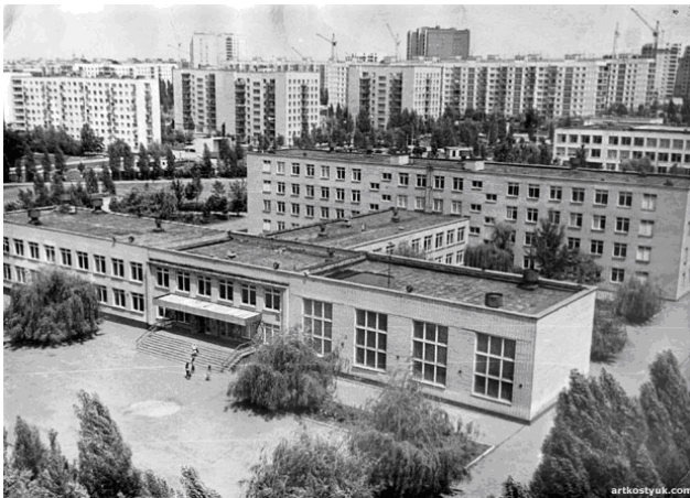
Рис. 14. Архивное фото здания школы № 99, разрушенное оползем. На заднем плане хорошо видна высокая плотность застройки ж/м “Тополь-1”. Фото А. Костюка
