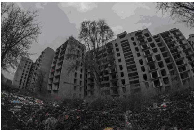
Рис. 17. Аварийный 9-этажный дом № 9 на ж/м “Тополь-1”. Фото Dance of December So... 2008
